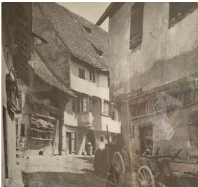
Rempart photographié du passage WILL avec à droite Maison Henri GROB épargné par l'incendie.
